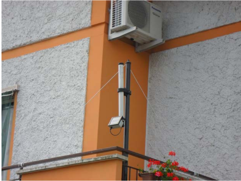
Punto di misura in continuo 1 – abitazione Ghisoni - Via Corbellini, 8
